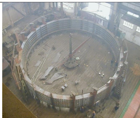
تجهیزات ژنراتور نیروگاههای برق آبی
