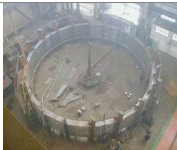
تجهیزات ژنراتور نیروگاههای برق آبی
